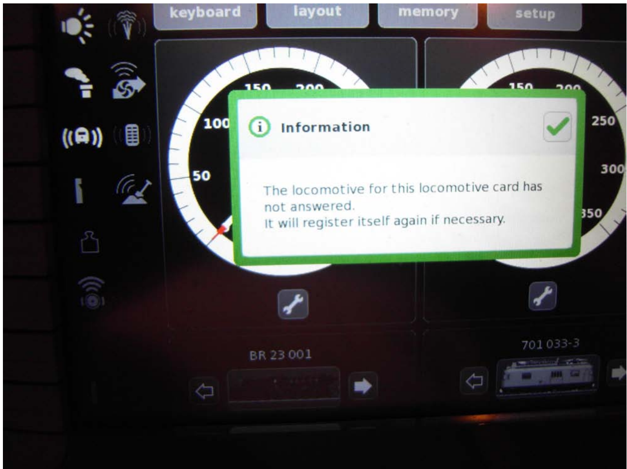
Foto n. 37: l'avviso segnala che la B3 23 001 non risponde (perché isolata in un binario)
