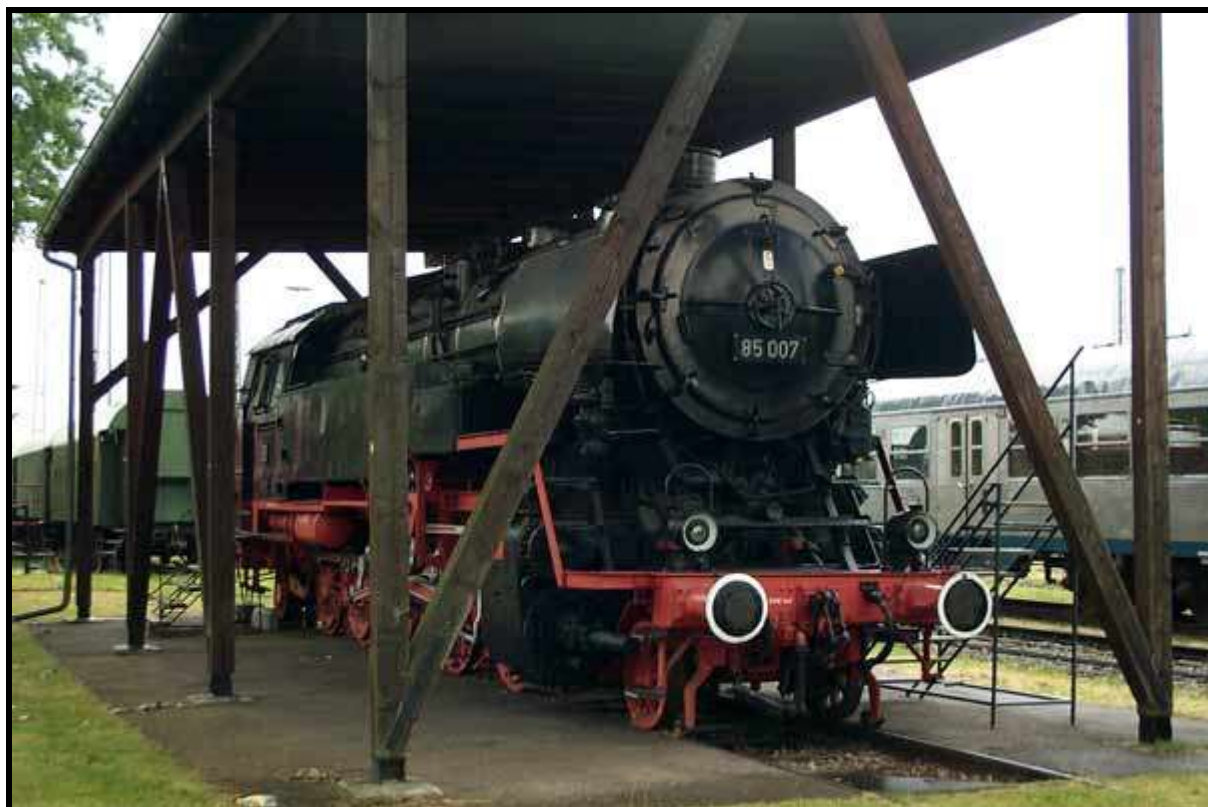
La tettoia ha delle travi da 25x25 cm (max 30x30) foto n. 2
