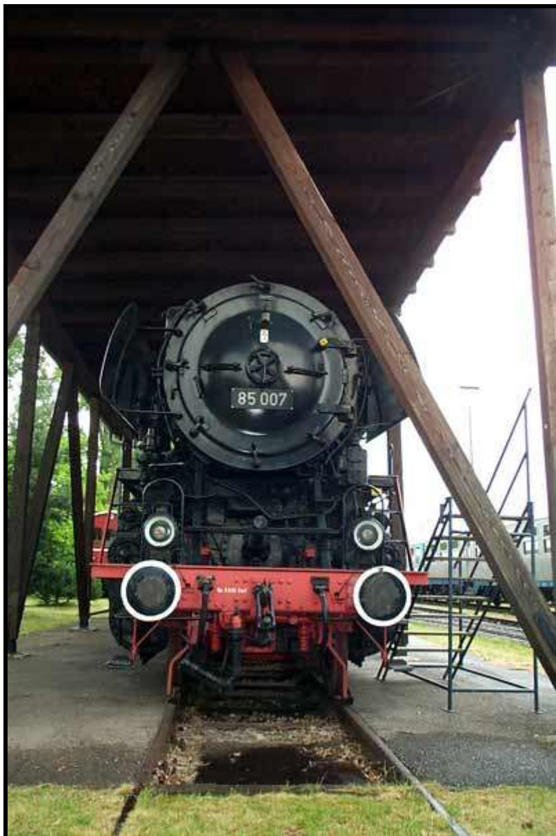
La tettoia dal lato senza uscita con travatura a "V" rovesciata sino a terra foto n. 3
