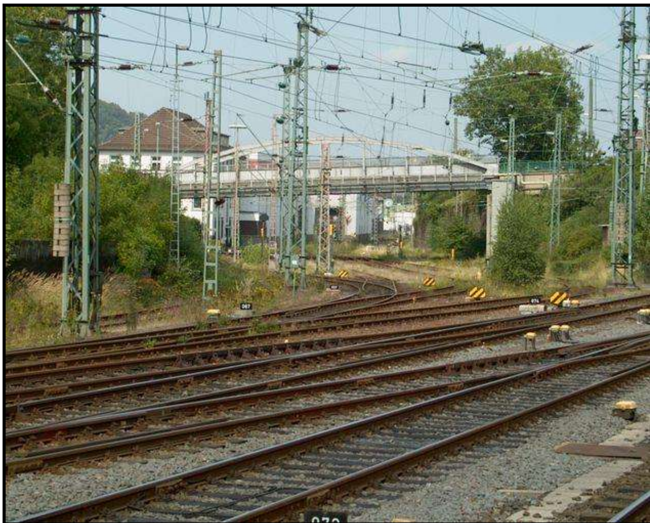
Foto n. 28: pali con tiranti, pali con contrappesi semplici e doppi, calate d'alimentazione DB, nella foto reale e altri particolari.
