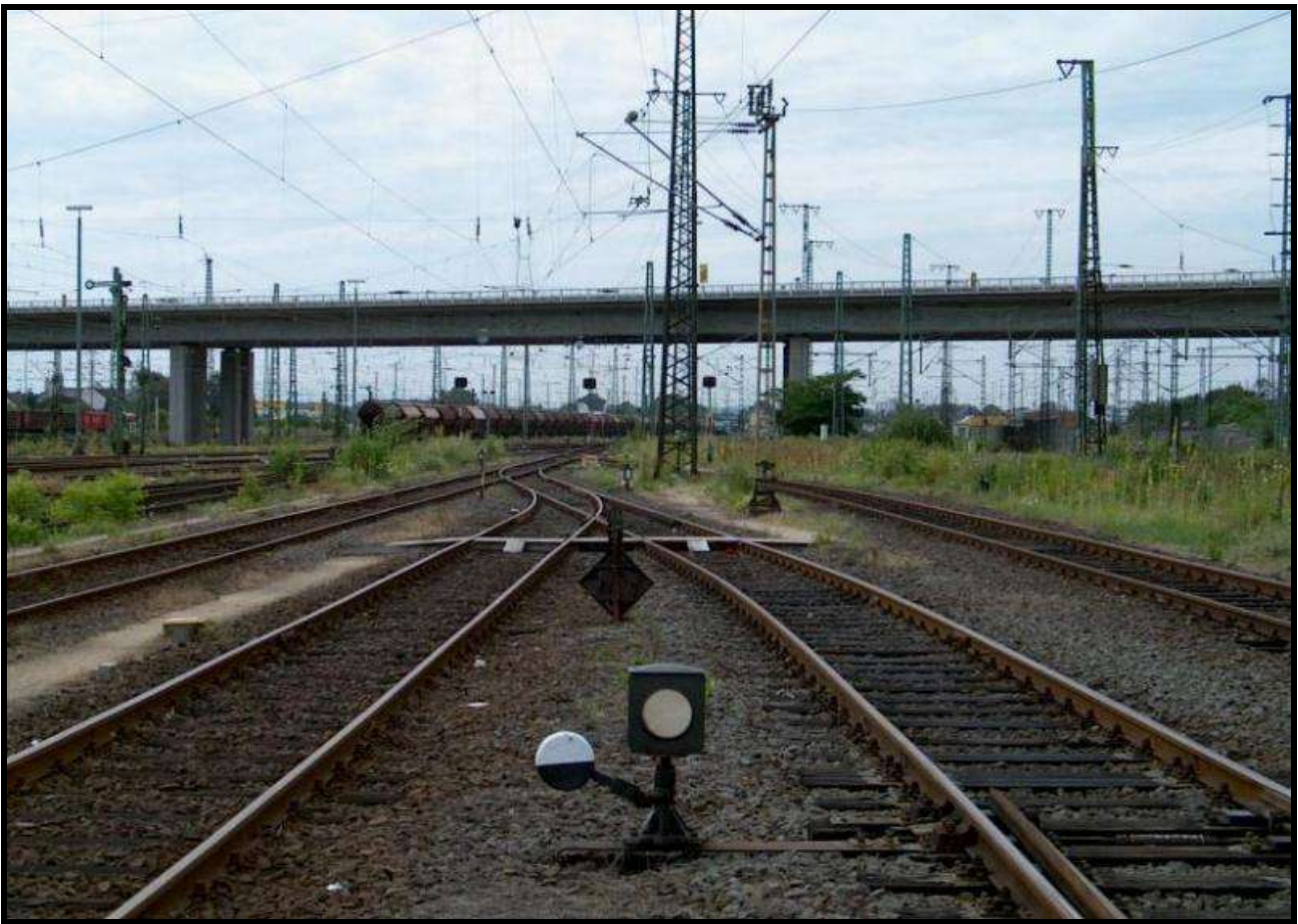
Foto n. 29: pali con mensole doppie, pali a torre con contrappesi doppi, calate d'alimentazione DB, nella foto reale e altri particolari.
