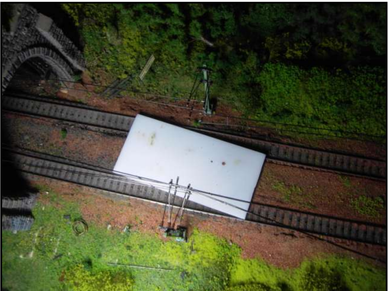
Foto n. 27: 2 pali opposti con doppie mensole durante la lavorazione.
