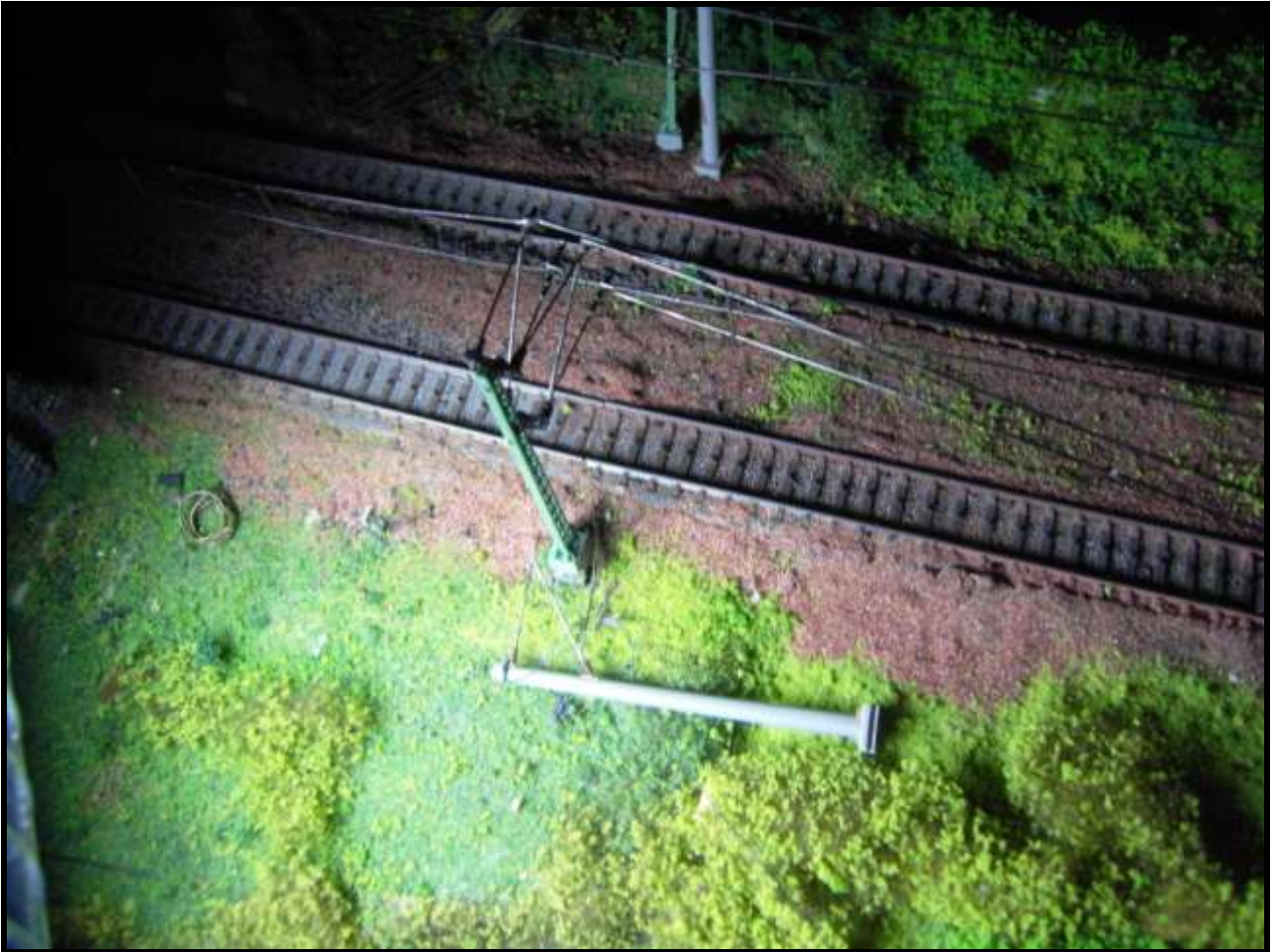
Foto n. 25: la sostituzione del primo palo.
