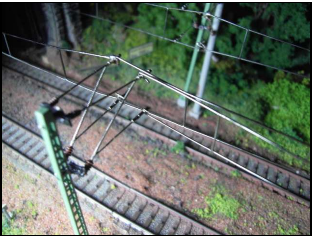
Foto n. 26: particolare dei 2 pali opposti durante la lavorazione.
