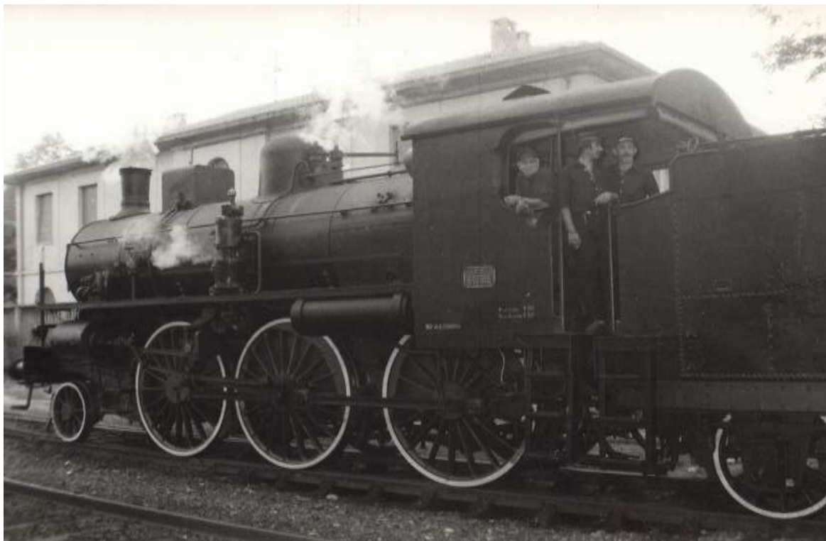
La Gr.640, foto Simap, con carrello anteriore di tipo "italiano" http://www.3rotaie.net/forum/topic.asp?TOPIC_ID=1954
